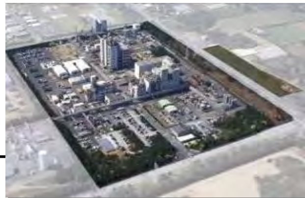
Kashima Factory (Kamisu-shi, Ibaraki, Approx. 130,000 m 2 )
