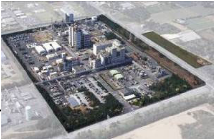
Kashima Factory (Kamisu-shi, Ibaraki, Approx. 130,000 m 2 )
