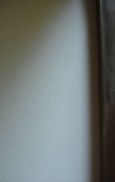
修学院離宮の漆喰仕上げ「ばらり」 (客殿・外壁)
