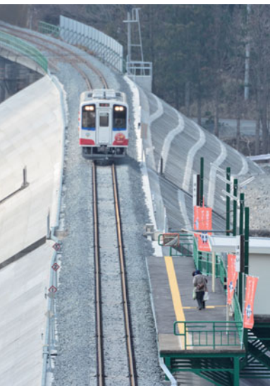
津波に強い構造で復旧 (2013.4.4/甫嶺駅)
