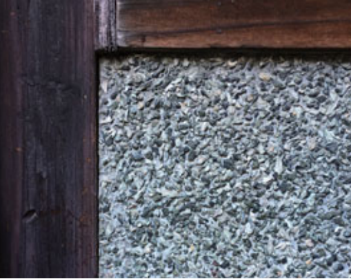
町家や昭和時代の建築の外壁などによく使われている「蛇紋岩洗い出し」
