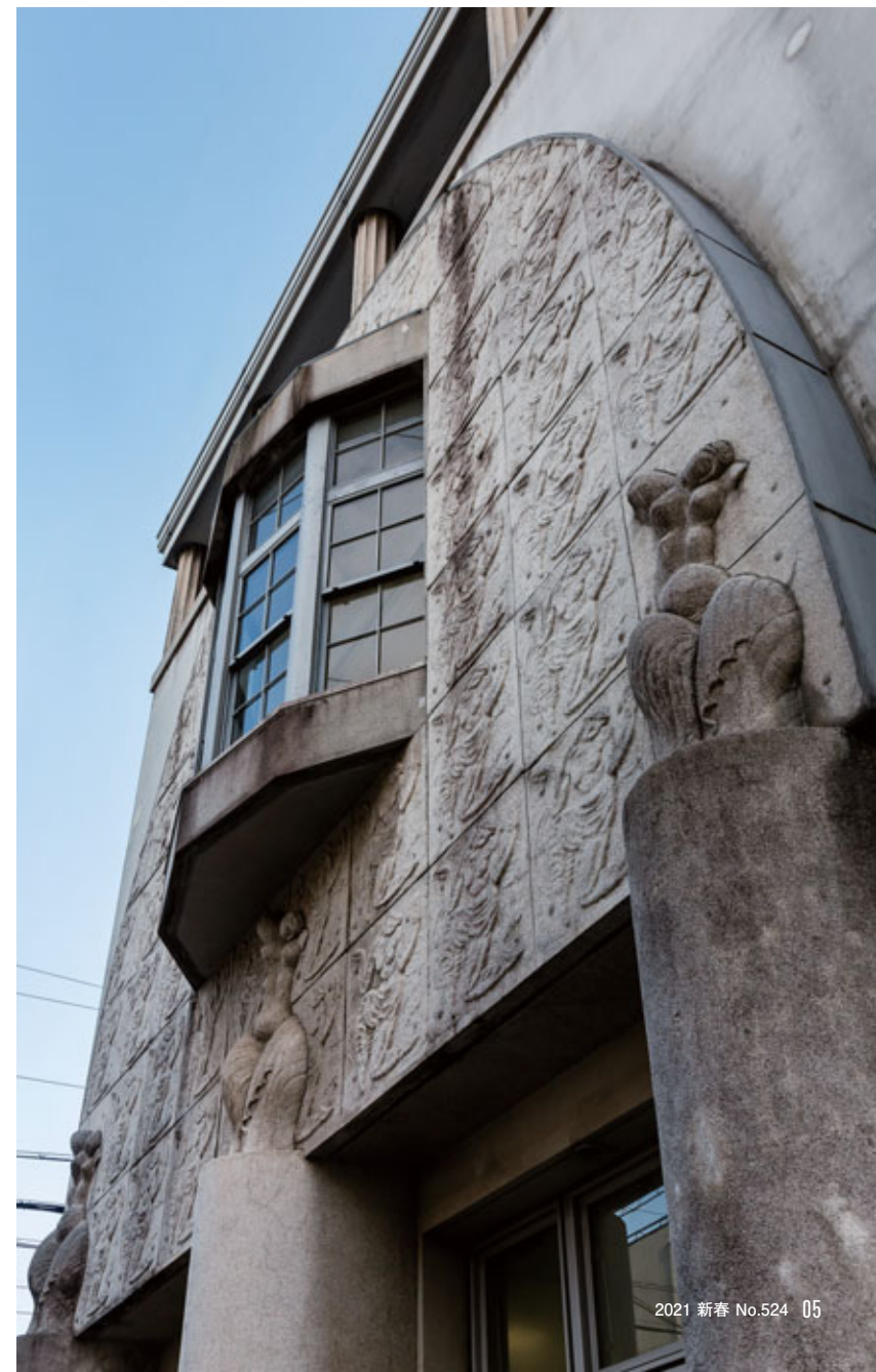
旧京都中央電話局西陣分局舎の外壁レリーフに見られる「洗い出し」（撮影：エスエス大阪 津田裕之）
