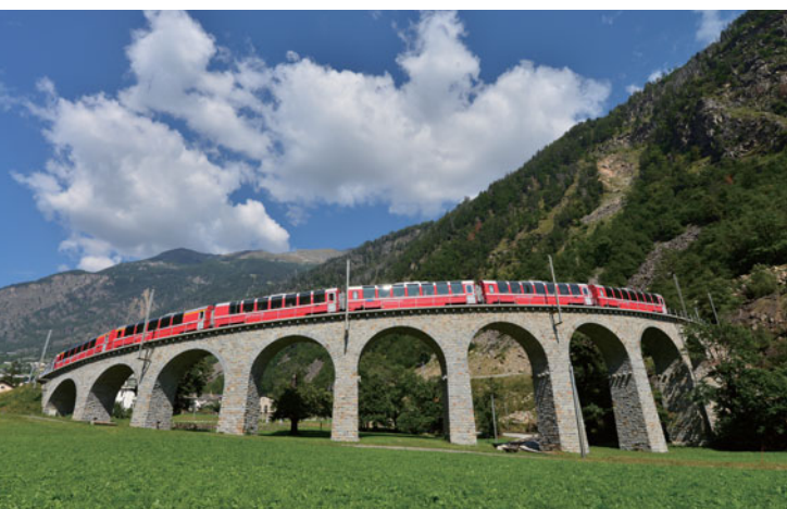
ベルニナ線のブルージオ360度ループ橋(2012.9.6/レーティッシュ鐵道)
