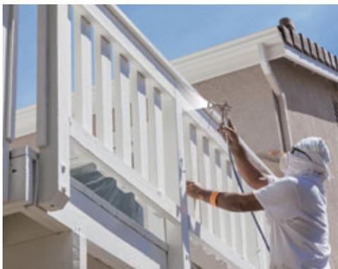
のです。また、外装には通常2〜3層塗装が施されています。下塗りは下地の目止めや接着性の向上、中塗りは上塗り塗膜の補強による均一化、上塗りは美観や耐候性を付与する仕上げの役割を果たしています。
