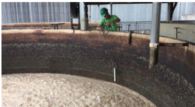
バイオエタノール製造の発酵槽
