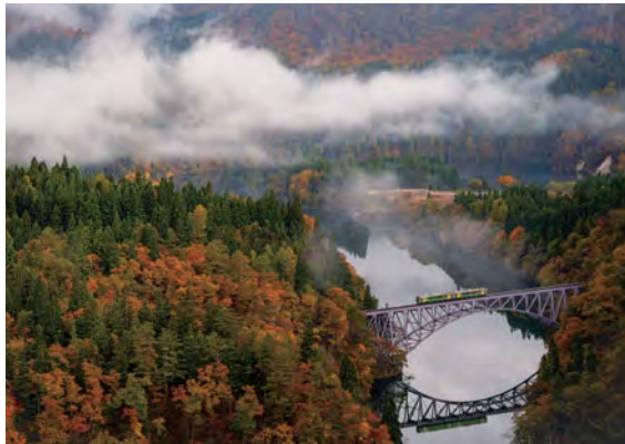
錦秋の第一只見川橋梁 (2021.11.6/会津松原～会津西方)
