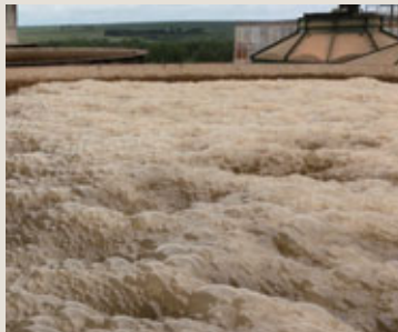
写真1 オーバーフローしそうな反応タンク
