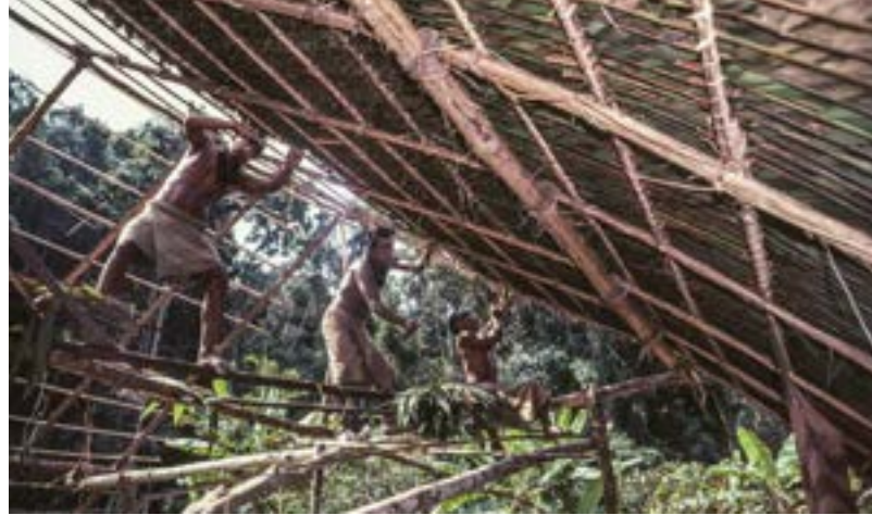
家づくりをしている様子。木で骨組みを作り葉で屋根を葺く
