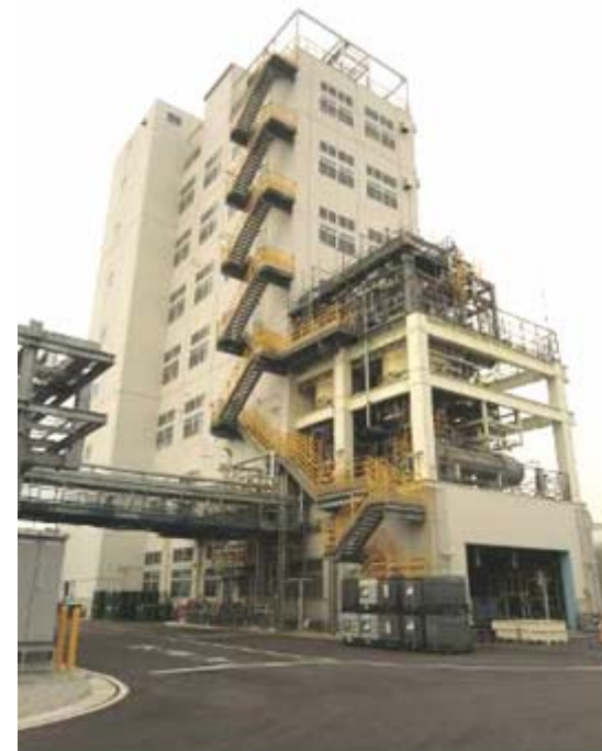
パイロット設備を導入した 衣浦工場AOAプラント
