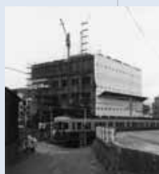
建設中の本社本館(72)
