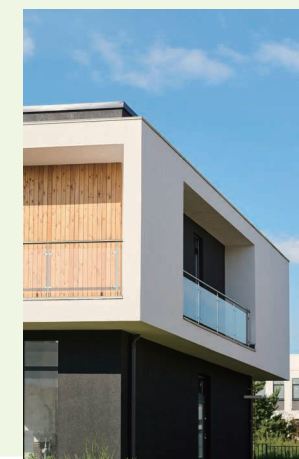
家の断熱材、シーラント
